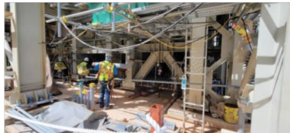
Piping installation is ongoing below HRSG #3
