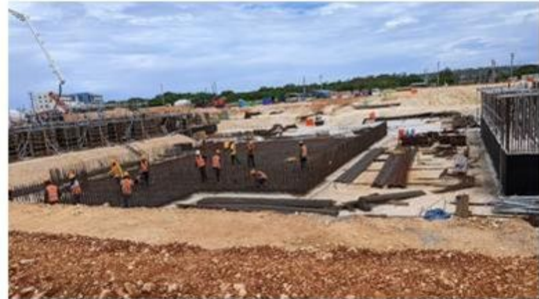
HRSG (#2 of 3) Rebar work
