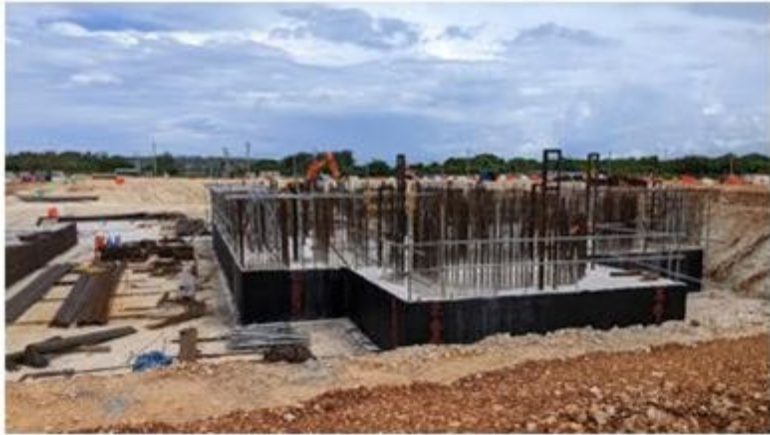
HRSG (#1 of 3) Rebar work
