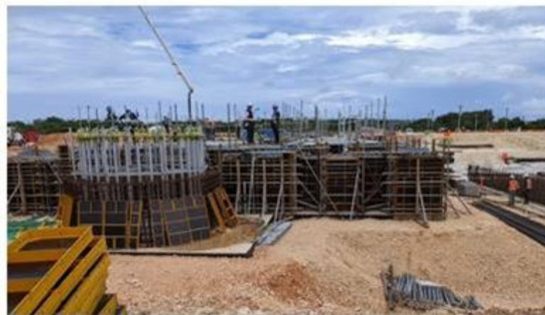
HRSG (#3 of 3) Foundation Pouring
